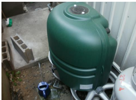
雨水タンクの設置により雨水の有効利用
